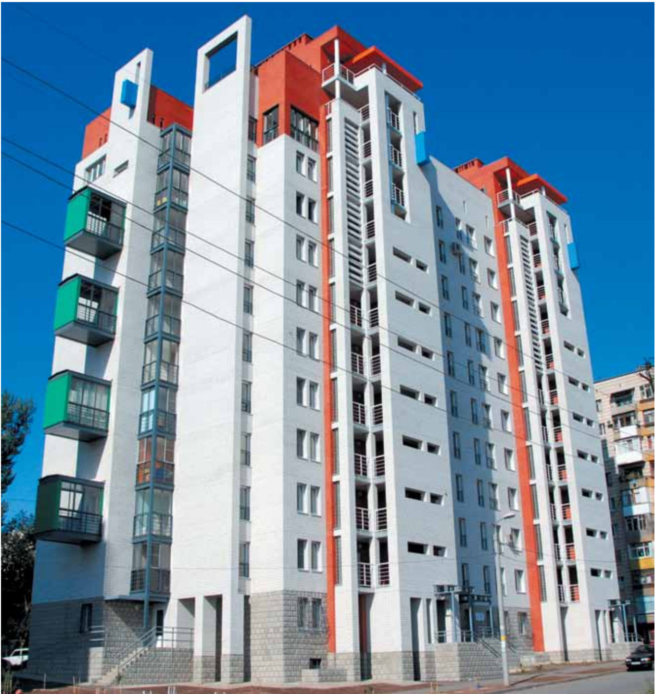
Жилой дом эконом-класса по ул. Авиаторская, 3А, на Тулака, 2008 г.
