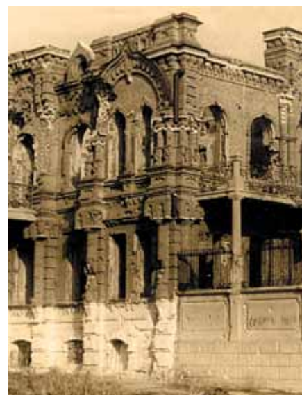
Фрагмент разрушения юго-восточного фасада. Фото архитектора Ф.М. Коимшиди (компьютерное восстановление П. Олейникова)
