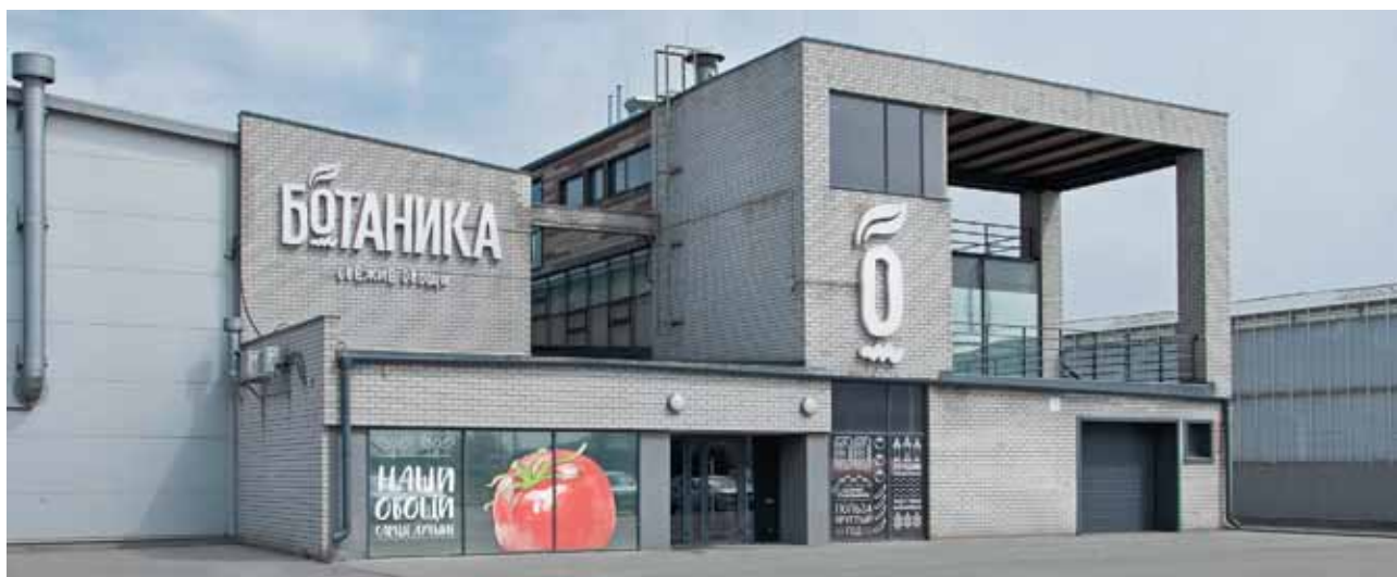
Административный корпус тепличного хозяйства «Ботаника». Архитектор В. А. Русанов
