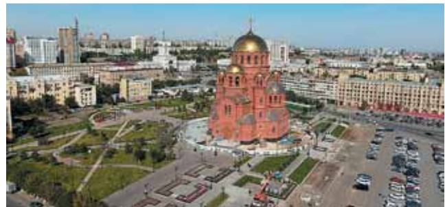
Храм Александра Невского, работа выполнена членом Ассоциации «Проектный комплекс «Нижняя Волга» – АО «Приволжтрансстрой»
